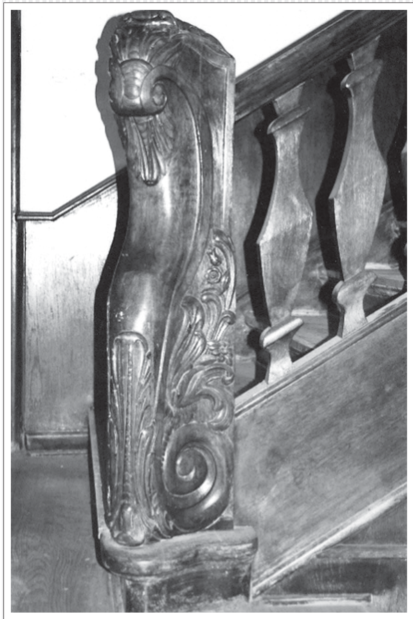
Balustrada w budynku przy ul. Koszalińskiej 49 w Sławnie, 1995
