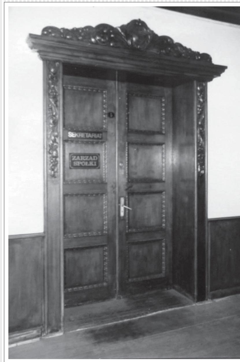
Drzwi w budynku przy ul. Koszalińskiej 49 w Sławnie, 1995
